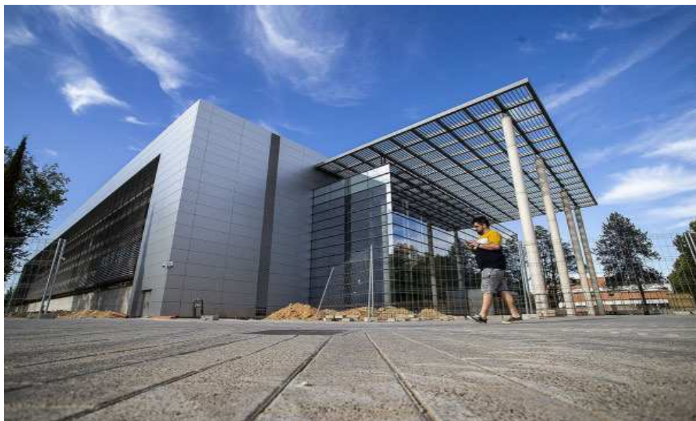
Edificio de la futura Ciudad de la Justicia Giner de los Ríos de Albacete, que este año empezará a tener actividad. / J.M.E.
